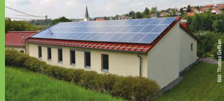
PV-Anlage auf dem Ev. Gemeindehaus in Unterweissach
