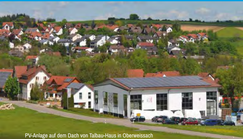
PV-Anlage auf dem Dach von Talbau-Haus in Oberweissach
